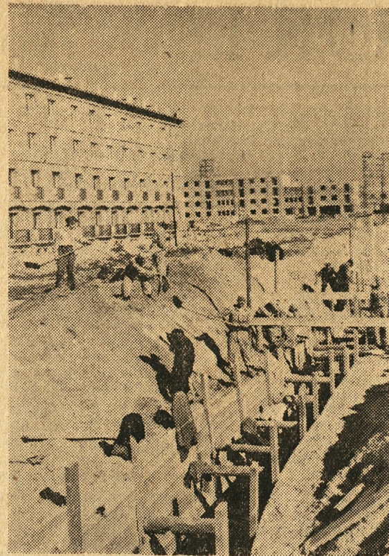
CAF — fot. Kondracki Budowa osiedla C-1 w Nowej Hucie. Na zdjęciu: 39 brygada SP przy wykopach kanalizacyjnych osiąga 250 proc. normy.
