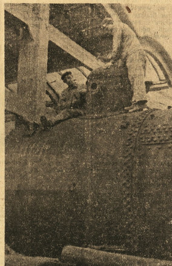
W Gdańsku-Wrzeszczu prowadzone są intensywne prace przy rozbudowie Akademii Medycznej. Na zdjęciu: Maksymilian Chyrek i Kazimierz Zacharski podczas montażu kotłowni centralnego ogrzewania, które obsłuży gmach Kliniki
