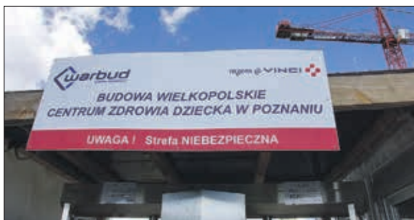
Na teren budowy można wejść tylko przez specjalne bramki. Już niedługo codziennie będzie je przekraczać nawet 450 robotników.
