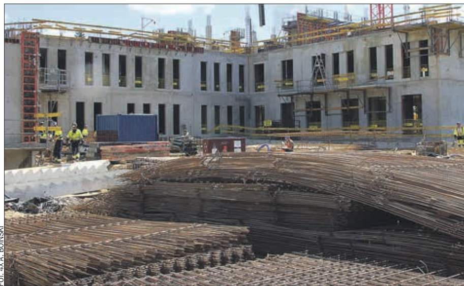
Srednio każdego dnia wylewana jest zawartość czternastu samochodów „gruszek” z betonem, a zbrojarze wkręcają ładunek TIR-a ze stalą.
