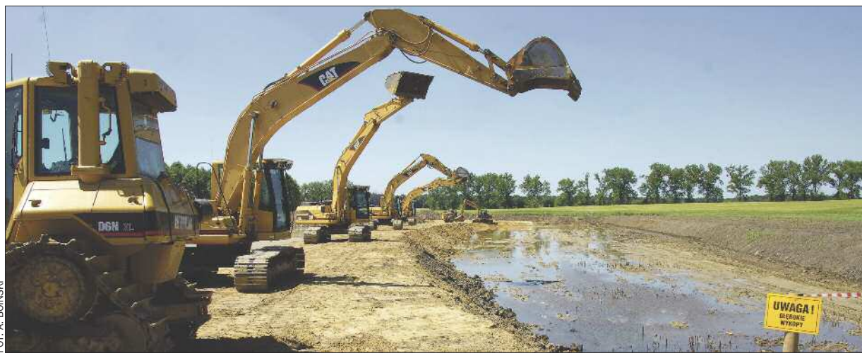
Wiele osób negatywnie ocenia odebranie samorządowi nadzoru nad ważnymi instytucjami, na przykład Wielkopolskim Zarządem Melioracji i Urządzeń Wodnych. Na zdjęciu – ostatnia nadzorowana przez WZMiUW inwestycja na Rowie Złotnickim w Strzeszynie.
