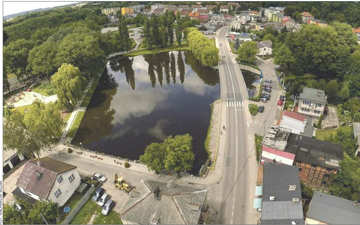
Samorząd województwa zrealizował w latach 2014-2018 wiele inwestycji drogowych, np. w Wyrzysku (na zdjęciu DW nr 194).
