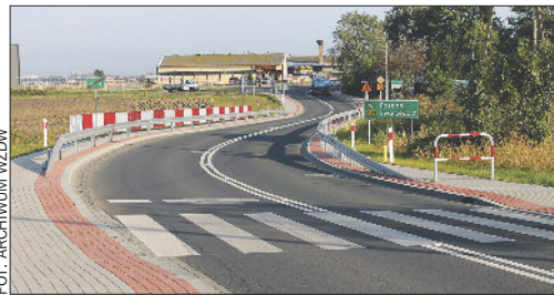
FOT. ARCHIWUM WZDW Wyremontowana droga z Szamotuł do Obornik.
