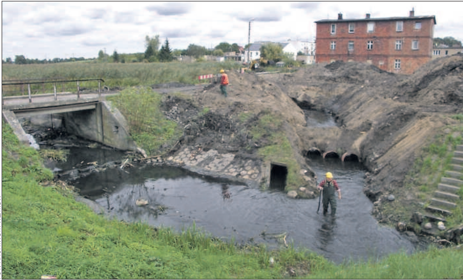
Prace w Przebądowie rozpoczęły się na początku września.
