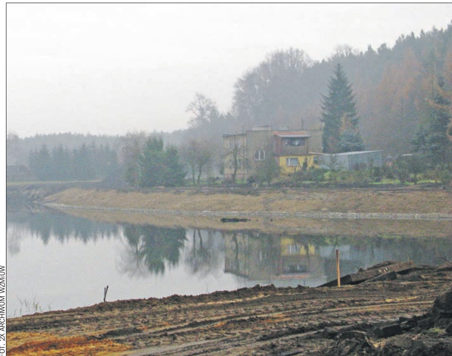
Budowa zbiornika w Miedzichowie.
