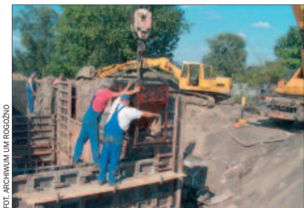
W ramach projektu przewiduje się budowę 369 km sieci kanalizacyjnej. Na zdjęciu podobna inwestycja realizowana w Rogoźnie ze środków ZPORR.
