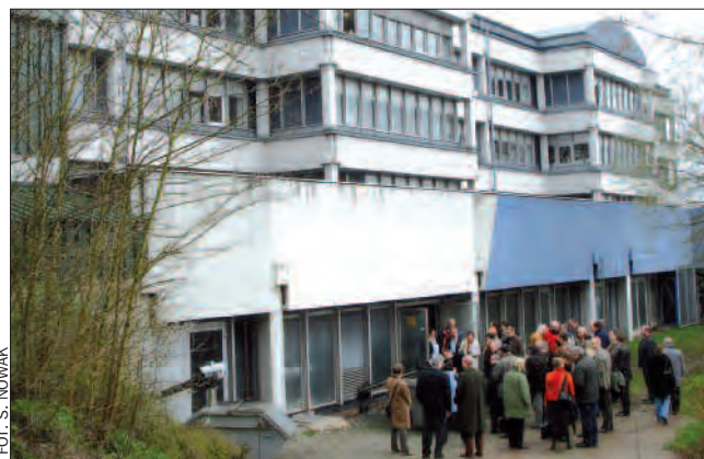
Zespół Szkół Zawodowych w Bad Hersfeld jest wyposażony w biokotłownię, która umożliwia ogrzewanie budynku dzięki spalaniu zrębków drewna.
