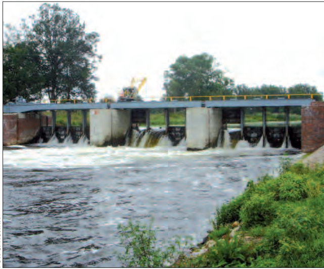
FOT. S. NOWAK Jedną z tam na Noteci podtrzymujących poziom wody niezbędny do prowadzenia żeglugi.
