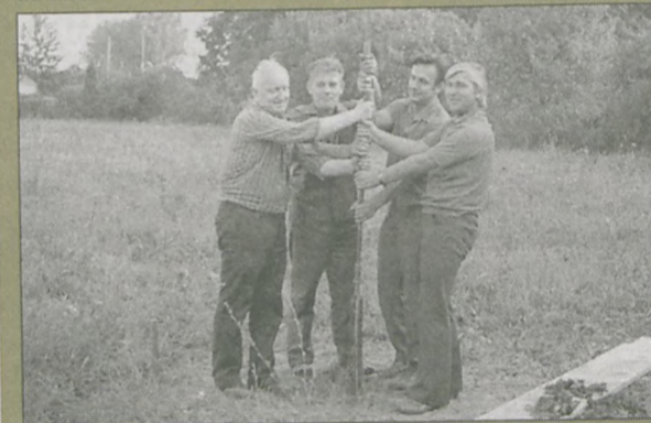
Zanim przystąpiono do budowy, przez kilka tygodni prowadzono badania gruntu. Ręczne odwierty wykonano w kilku miejscach działki, na której miał stanąć kościół i klasztor
