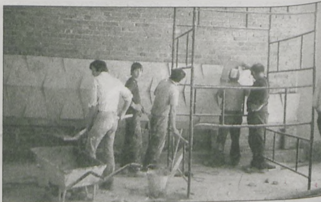
Prace wykończeniowe we wnętrzu kościoła trwały jeszcze po uroczystości konsekracji
