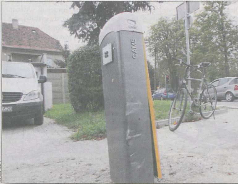
Zniszczony szlaban na osiedlu przy ul. Kobylińskiej
