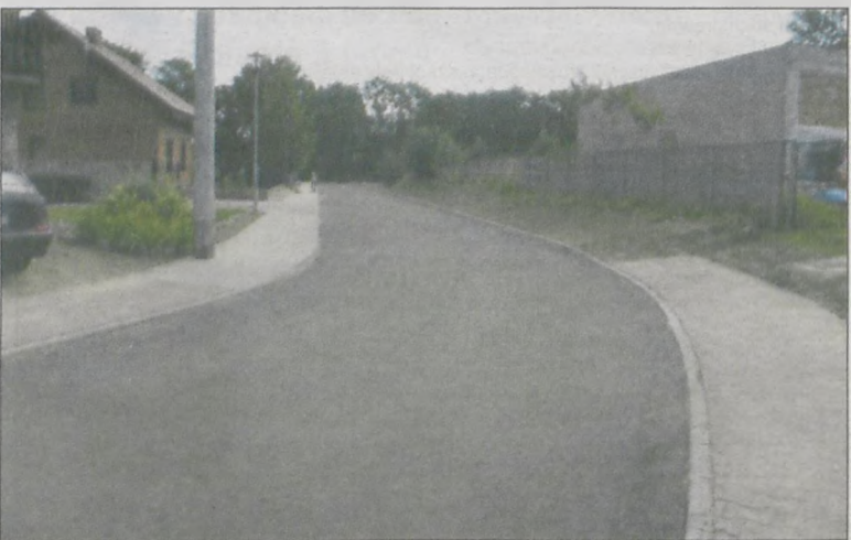
Nowo wyremontowana ulica Sikorskiego w Rozdrażewie
