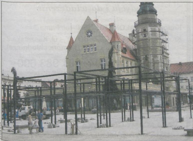
Stan robót budowlanych na koniec sierpnia
