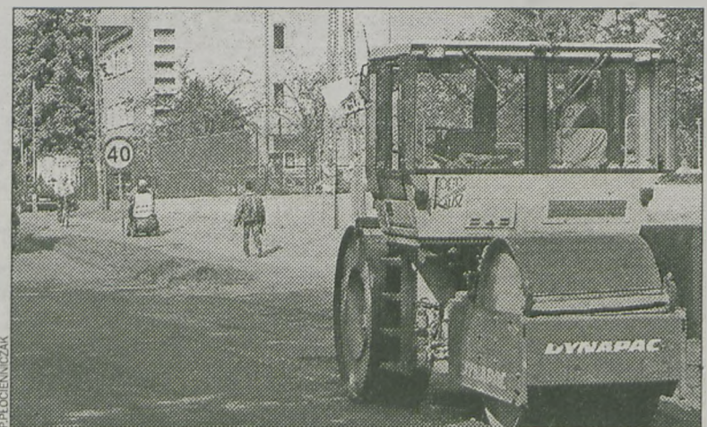
Remont zatrzymał się, bo nie dowieziono na czas asfaltu
