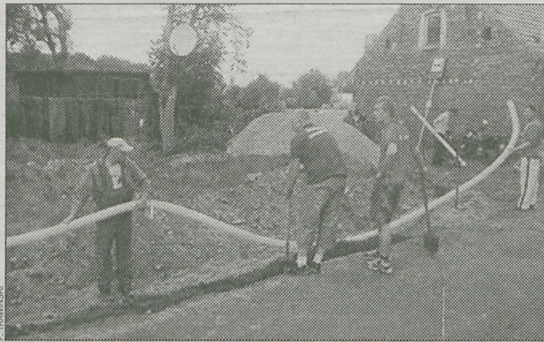
Mieszkańcy w trakcie zakładania rur melioracyjnych
