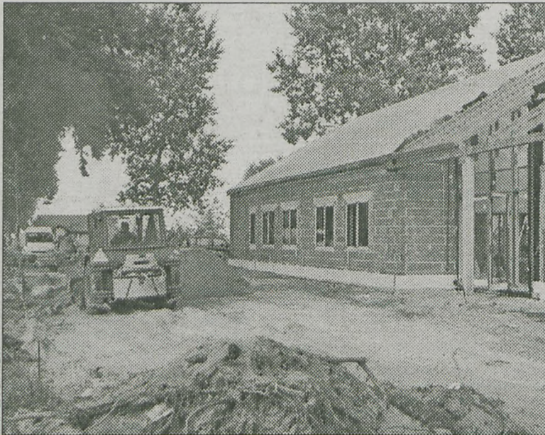
Trwają intensywne prace wykończeniowe świetlicy i terenu wokół budowy
