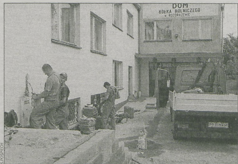
Firma wyłoniona w przetargu wymieniła tablice rozdzielcze od prądu
