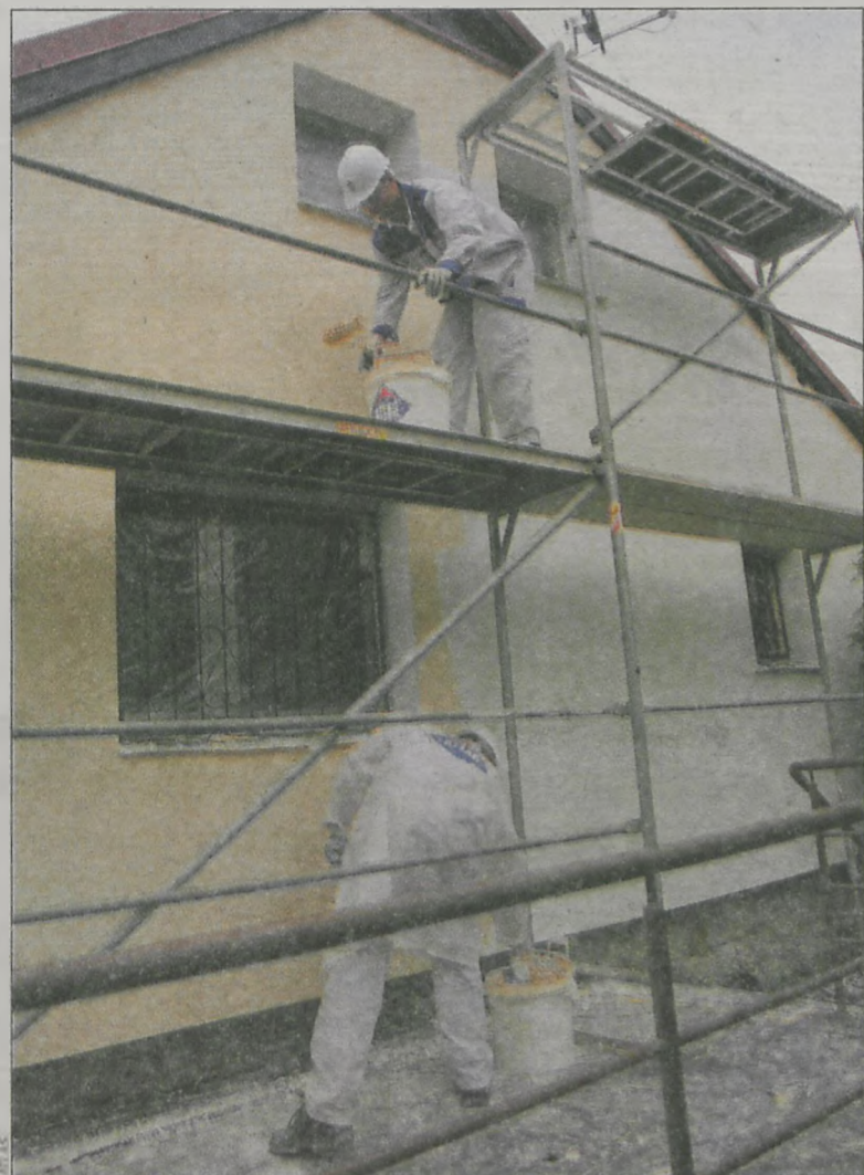
Tego typu prace wymagają doświadczenia i umiejętności budowlanych
