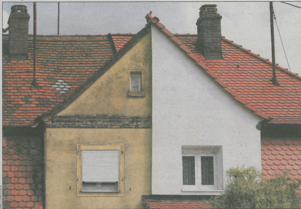
Nie ma wątpliwości, która część domu lepiej przetrwa zawieruchę i śnieg
