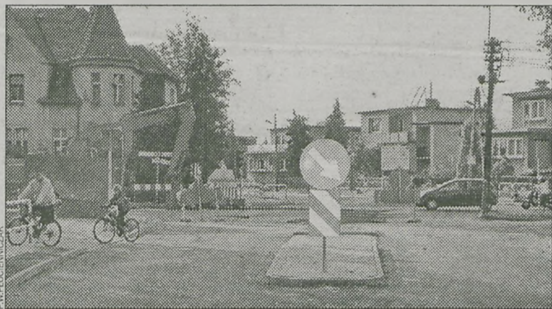
Dyrekcja dróg krajowych nie da pieniędzy na budowę ronda na skrzyżowaniu przy Gimnazjum nr 2
