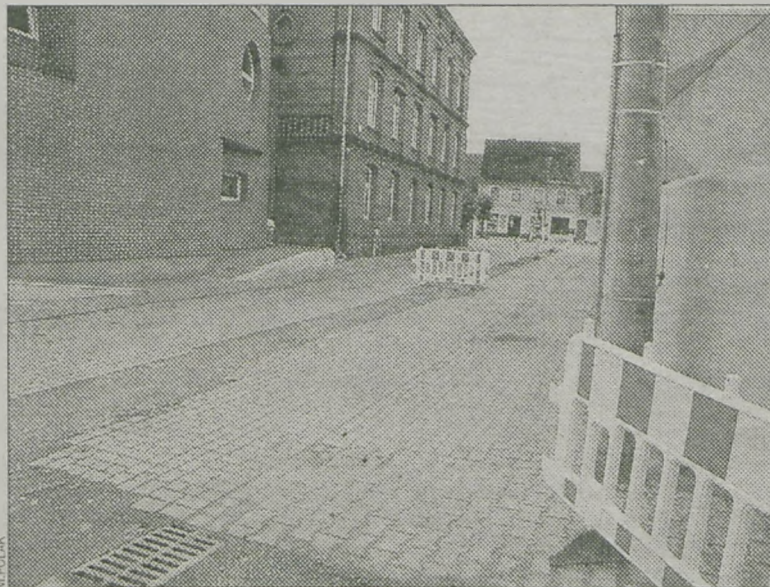
Ul. Szkolna została już skanalizowana, trzeba jeszcze naprawić nawierzchnię
