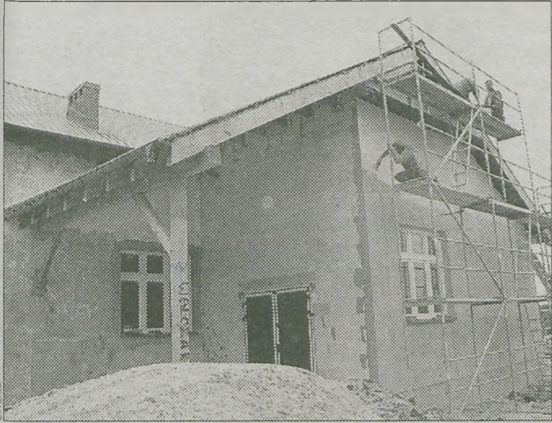
W Guzowicach dąbiega końca remont elewacji
