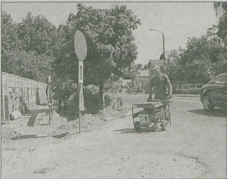
W tej chwili PZD nadzoruje przygotowanie terenu pod budowę ronda
