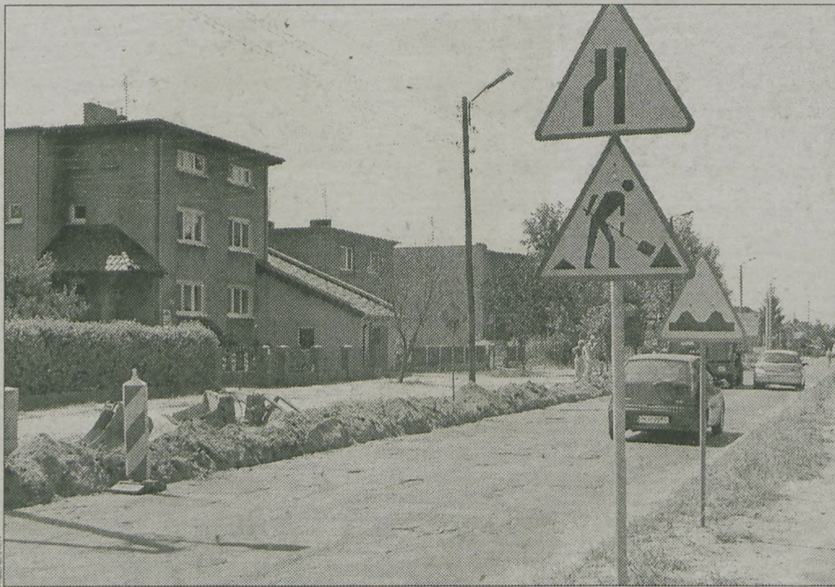
Obecnie mogą tu występować niewielkie utrudnienia w ruchu drogowym
