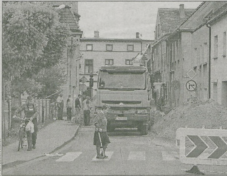
Na ul. Krobskiej prace prowadzone są na krótkim odcinku
