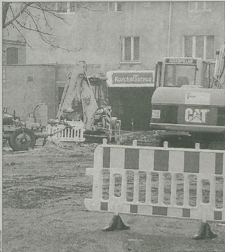
W tej chwili trwają tam prace nad budową kanalizacji
