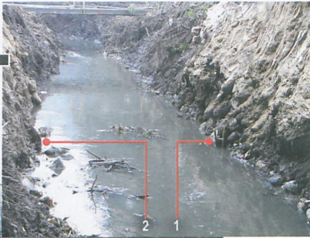
Strumień Junikowski po rozebraniu mostka (październik 2006 r.) – widok od południa, 1- pal wschodni; 2- pal zachodni fot. Piotr P. Ruszkowski
