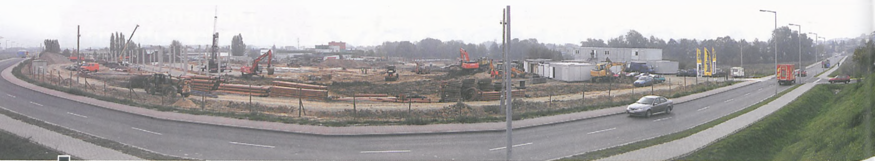
Panorama placu budowy centrum handlowego FACTORY przy ul. Dębieckiej. Wykonawcą jest Budimex Dromex S.A. fot. Piotr P. Ruszkowski
