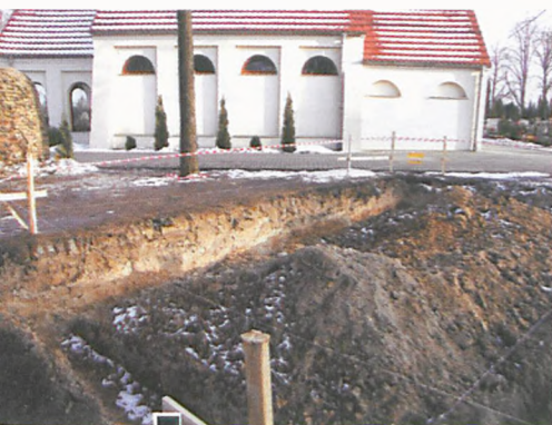
Wykop pod fundamenty budynku fot. Piotr Paweł Ruszkowski
