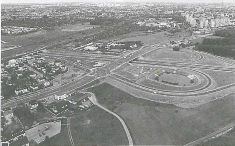
Współczesny węzeł Dębina z lotu ptaka. Przebieg, oddanej do użytku we wrześniu 2003 r., autostradowej obwodnicy Poznania, jest zbliżony do projektu niemieckiego. Pierwotnie miała ona jednak przebiegać nad ul. Armii Poznań i nad torami kolejowymi. Ostatecznie jednak wybudowano ją „odwrotnie” – przebiega pod linią kolejową Poznań-Wrocław i pod ulicą Armii Poznań fot. Przemysław Maćkowiak.
