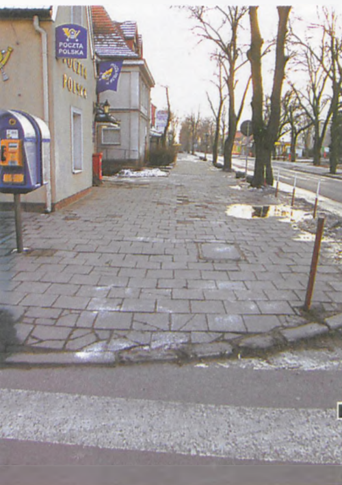
Chodnik przy wschodniej pierzei placu bł. Edmunda Bojanowskiego przeznaczony do inwestycji związanej z likwidacją barier architektonicznych fot. Piotr Paweł Ruszkowski
