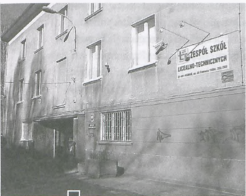
Budynek zespołu szkół
