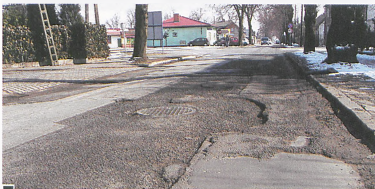
Fuszera po budowie kanalizacji sanitarnej na ul. 11 Listopada w okolicach pętli autobusowej fot. Paweł Jankowiak
