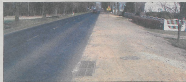
NA ODCINKACH, gdzie ma być wybudowany chodnik, wykonano już potrzebne odwodnienia
