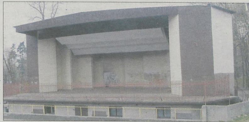
Ogrodzenie amfiteatru będzie demontowane przed każdą imprezą
