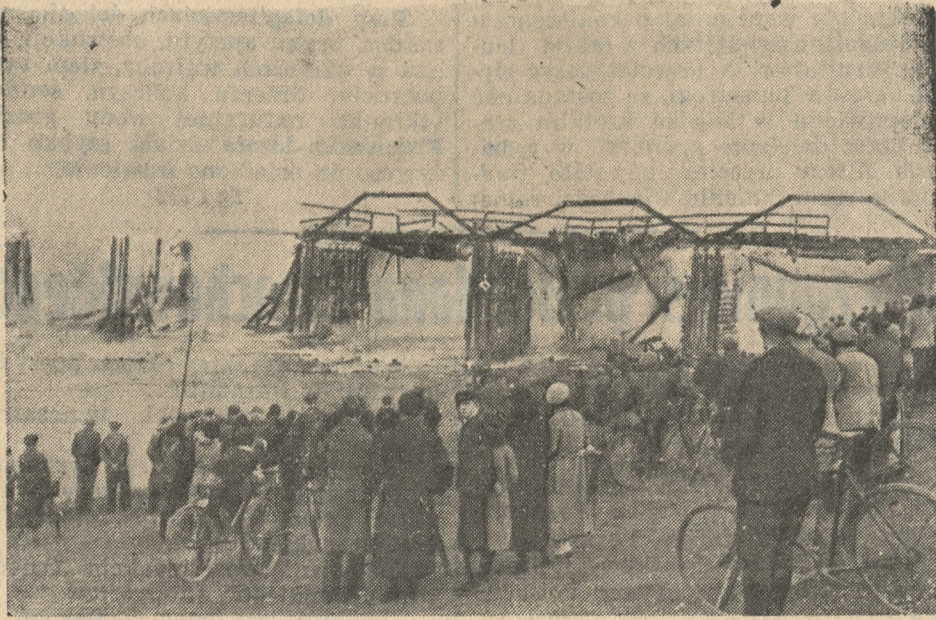
Pożar drewnianego mostu na Warcie pod Sierakowem.
