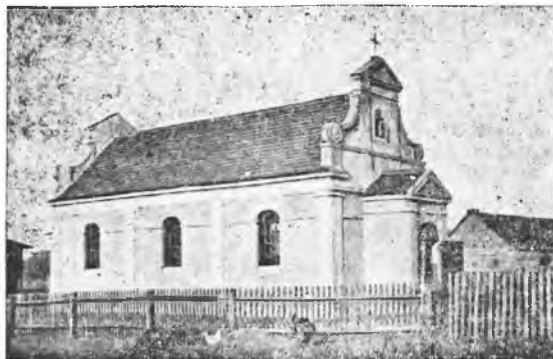
Wybudowany kościół w Stokach przez Ks. prob. Ogródowskiego
