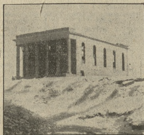
(Mury kościoła ub. zimy przed kontynuacją budowy).
