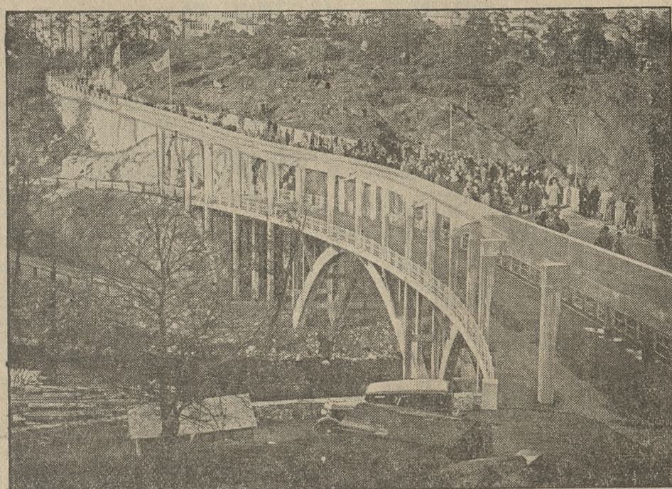
Oryginalny eksperyment inżynierski. W pobliżu Sztokholmu nad starym mostem zbudowano obecnie nowy most, przeznaczony wyłącznie dla ruchu kolejowego. W ten sposób powstały dwa mosty, jeden nad drugim.
