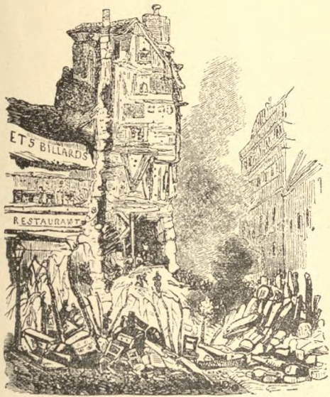
RUINES D'UNE MAISON, PLACE DE LA BASTILLE
