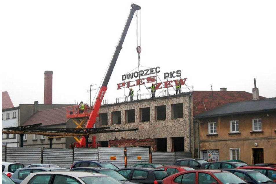
Rozpoczęcie prac rozbiórkowych dworca autobusowego w listopadzie 2016 r.
