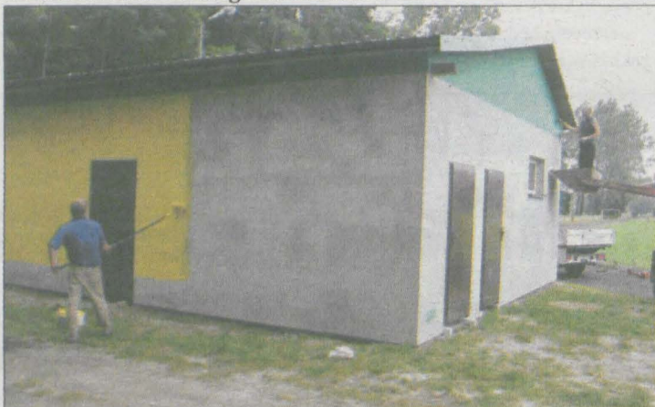
Na stadionie w Dominowie od poniedziałku trwało malowanie budynku domku klubowego.
