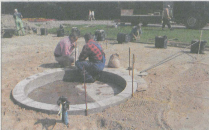
Na placu już stoi podstawa do fontanny. Teraz trwa układanie kostki.
