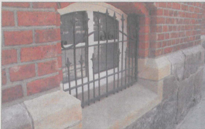
Piwniczne okna sądu zyskały nowy wygląd.
