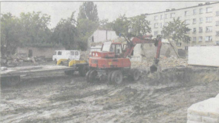
Ruszyła budowa nowej stacji paliw przy rondzie Solidarności.
