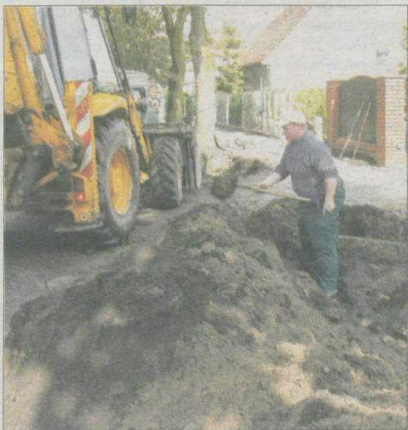
Na ul. Norwida powstaje nowy chodnik.
