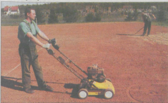
Prace na kortach wykonała firma Zibi z Konina.
