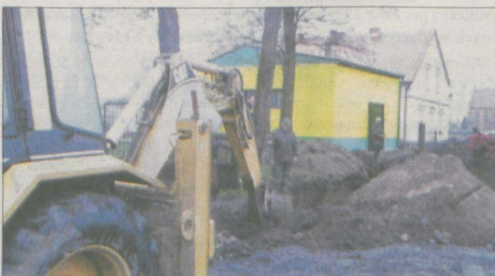
Prace rozpoczęły się przed tygodniem w Murzynowie Kościelnym przy należącej do gminy hydroforni.
