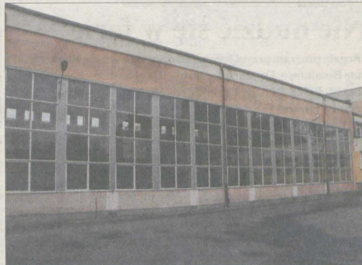
Na razie wykonawca zabezpieczył plac budowy. Właściwe prace przy modernizacji dachu w sali gimnazjum rozpoczną się za miesiąc.
