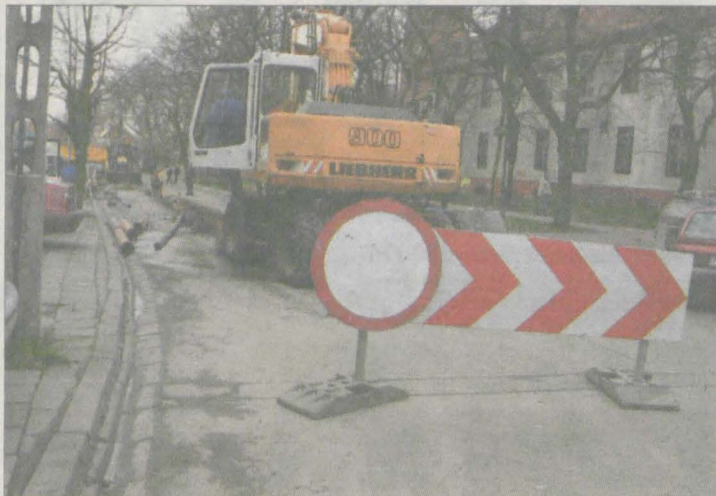
Prace przy budowie kolektora na ul. Wiosny Ludów.
