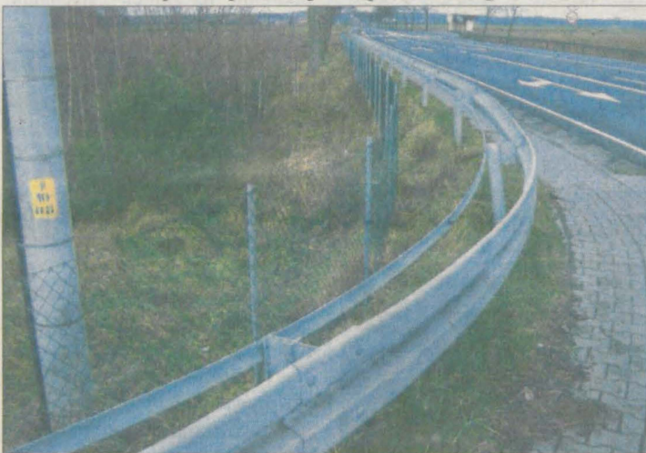
Obniżona siatka oddzielająca chodnik od rowu na pewno poprawia widoczność dla kierowców.
