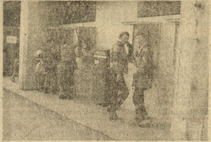
W Kaliszu we wnętrzu budynku pocztowego zainstalowano kilka automatów telefonicznych.
