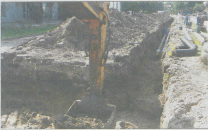
Budowa ciepłociągu
