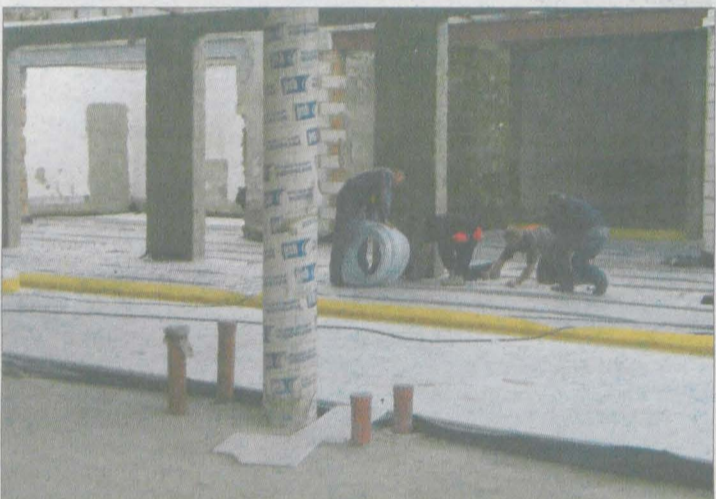
W części „butikowej” montowane jest ogrzewanie podłogowe.
