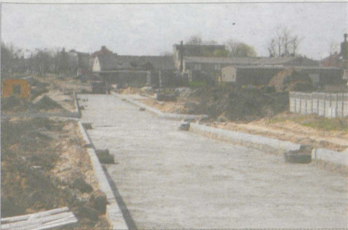
Ulica Weychana (połączenie Hallera i Topolskiej) to pierwszy etap budowy północnej obwodnicy. Dokumentacja na kolejne ma postać w tym i przyszłym roku.
