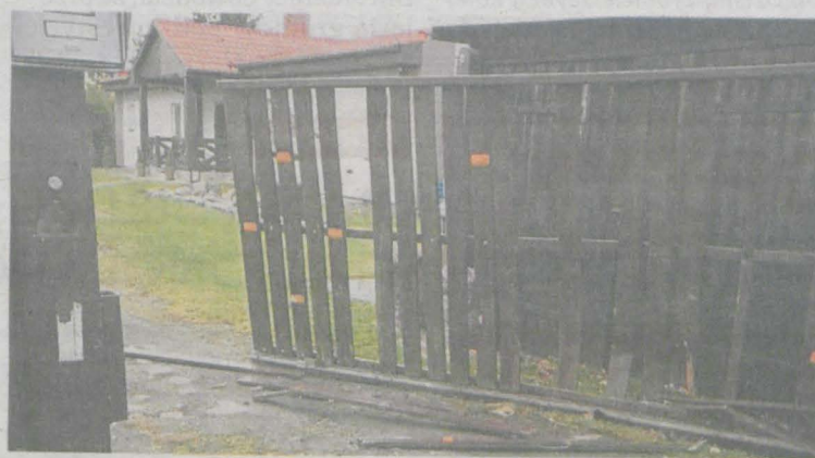
Brama posesji przy ulicy Folwarcznej została po raz kolejny zniszczona. Właścicielka apeluje o zamontowanie na drodze przed jej domem progów zwalniających
