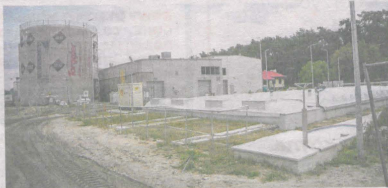
Już w przyszłym roku na oczyszczalni ścieków w Cielczy z osadów pościekowych może być produkowany dodatek do nawozów
