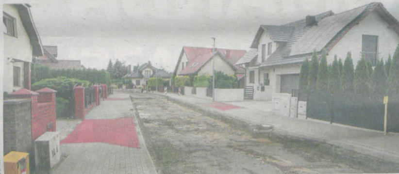
Ulica Jeżynowa w Jarocinie w trakcie przebudowy
