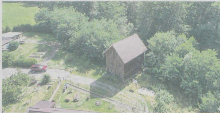
Po naprawie dachu, gmina ma przystąpić do remontu elewacji młyna nad Lutynią i do budowy ścieżki rowerowej
