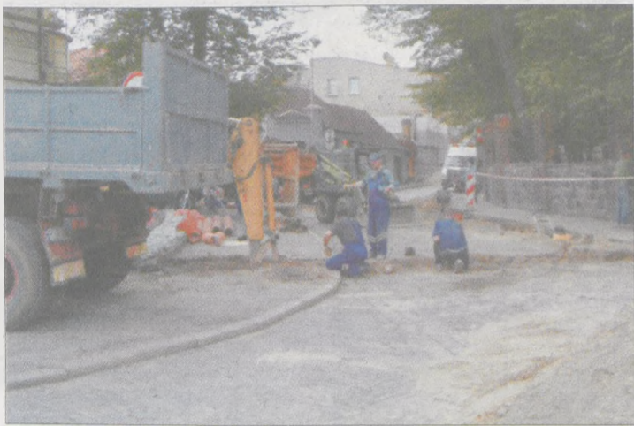
Kolektory na średzkiej starówce
