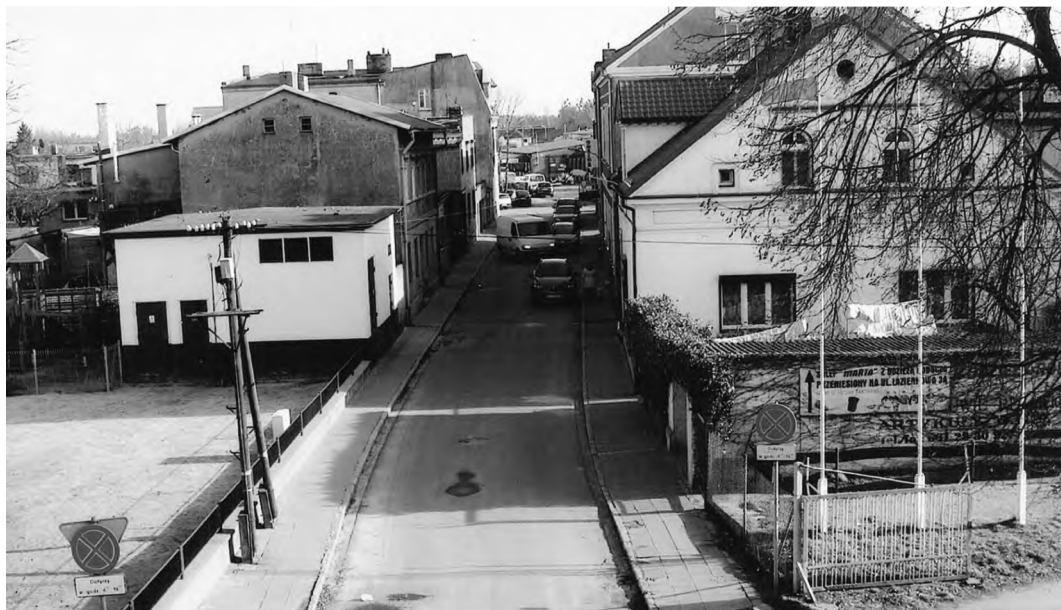
Widok na ul. Łazienkową z mostu na Warcie, Śrem, 2017 r. Fot. autorki
