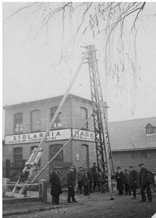
Stawianie słupów do przewodów elektrycznych przez Wartę. Śrem, 1937 r.
