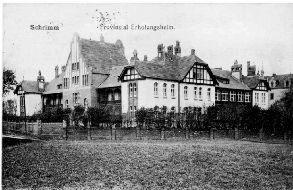
Nowy budynek Krajowego Zakładu dla Ubogich w Śremie, w którym w latach 1925-1930 mieścił się Zakład dla Dziewcząt Chorych na Jaglicę.
