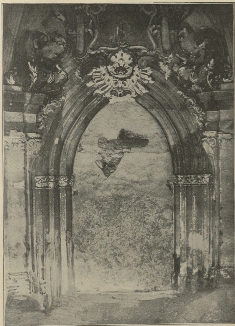
Obr. 21. Portál do kapituly.
