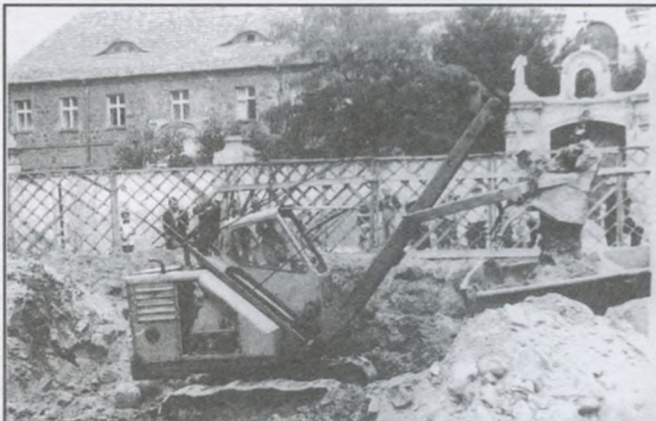
Wykopy pod budynek przy ul. Poznańskiej 18
