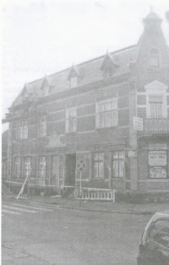
Prace remontowe w mieście.
