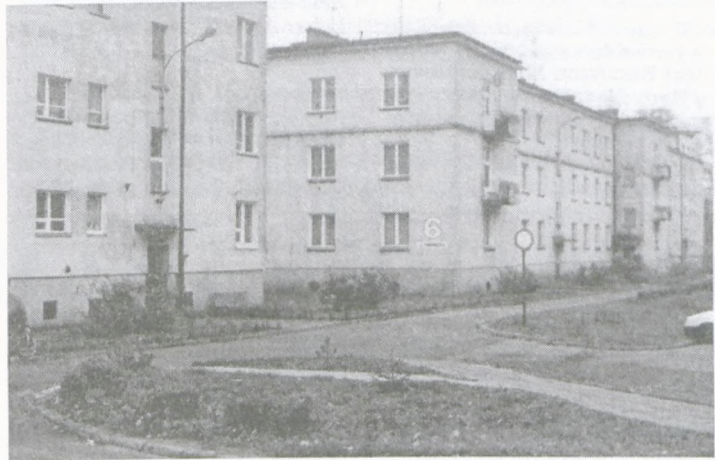
Bloki przy ul. Hibnera.
